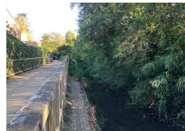
Overgang brug naar water
