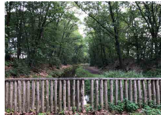
Zijaanzicht binnenzijde zuidwest
